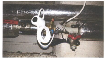
Vidaus šildymo sistemos balansavimo įranga su automatika
