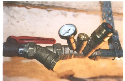
Vidaus karšto vandens sistemos balansavimo elementai
